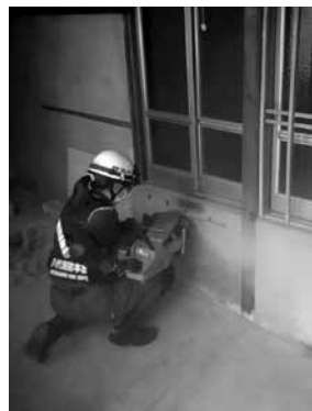
エンジンカッターによる破壊訓練
